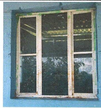
Foto 2: Colocacion de balcones a las ventanas del modulo de la cocina siendo aspecto de seguridad para los enseres y resguardarlos.
