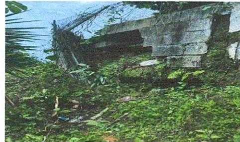
Foto 2: Mejoramiento 38 m 2 de muro de contención para resguardar la integridad física de niños y niñas de nuestro establecimiento.
