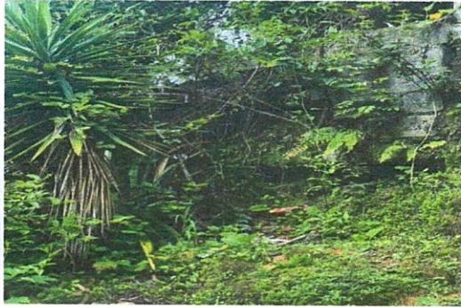
Foto 1: Mejoramiento 38 m 2 de muro de contención para resguardar la integridad física de niños y niñas de nuestro establecimiento.
